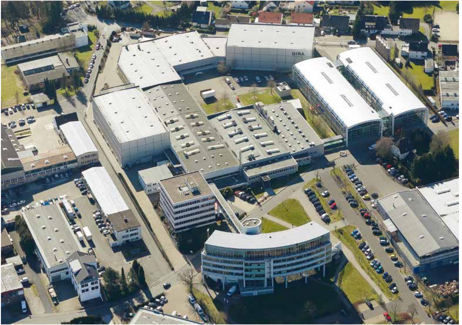
Vista aérea de las instalaciones de la planta de Gira en Radevormwald, Alemania.
