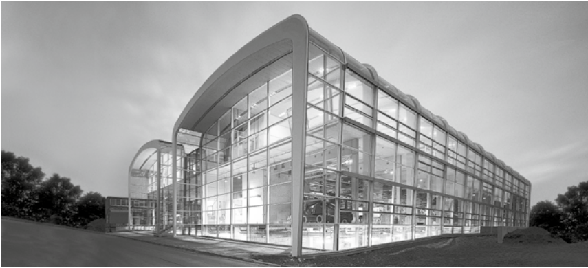
Nave de producción de Gira en Radevormwald
