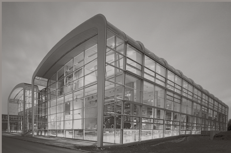
Edificio de producción de Gira en Radevormwald
