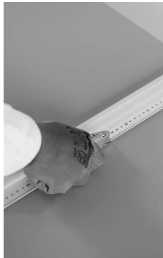
Sichtkontrolle beim Zuschnitt der Linoleumbahnen.
